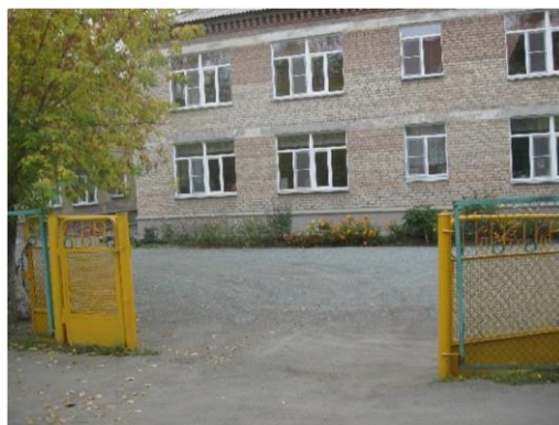
Въезд на территория транспорта
